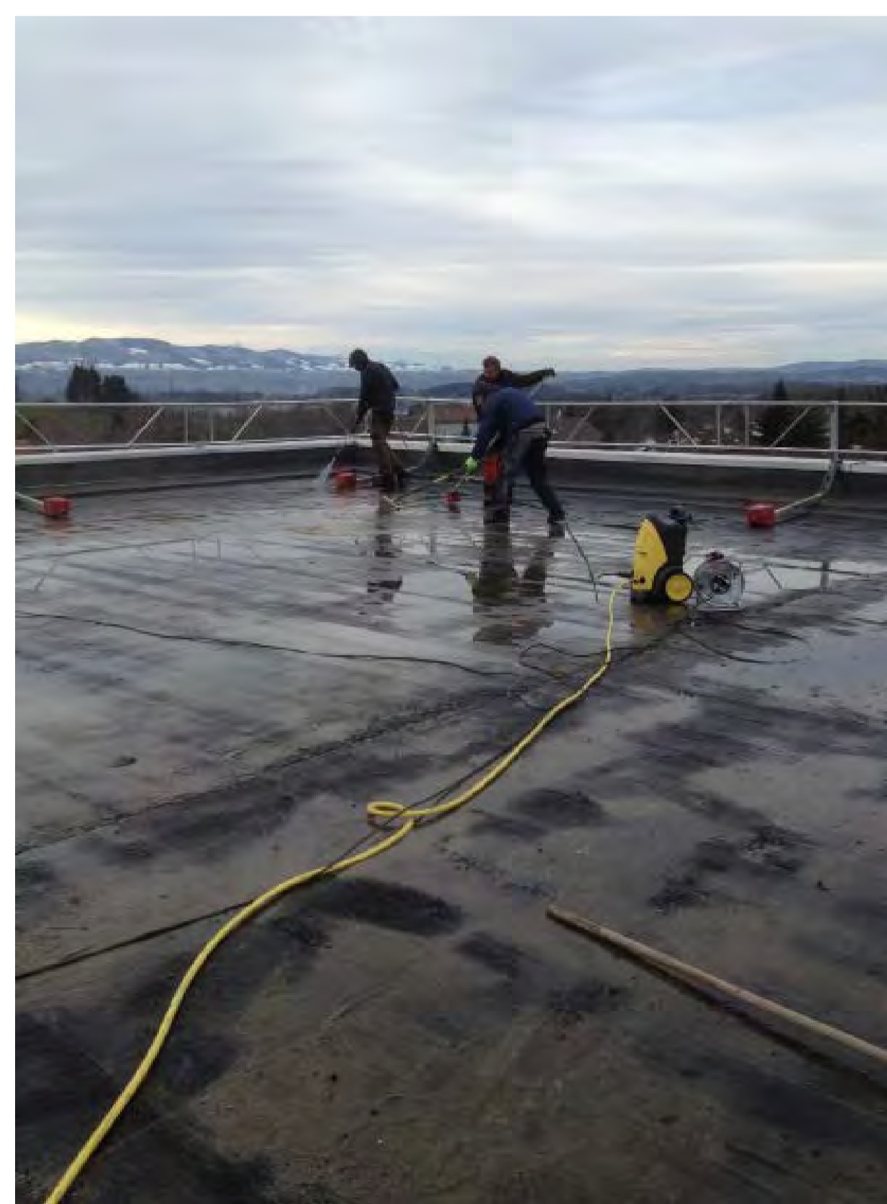
Dachsanierung vor dem Bau der Solaranlage auf einer Fläche von 800m 2 im Tobel 5 (2013).
